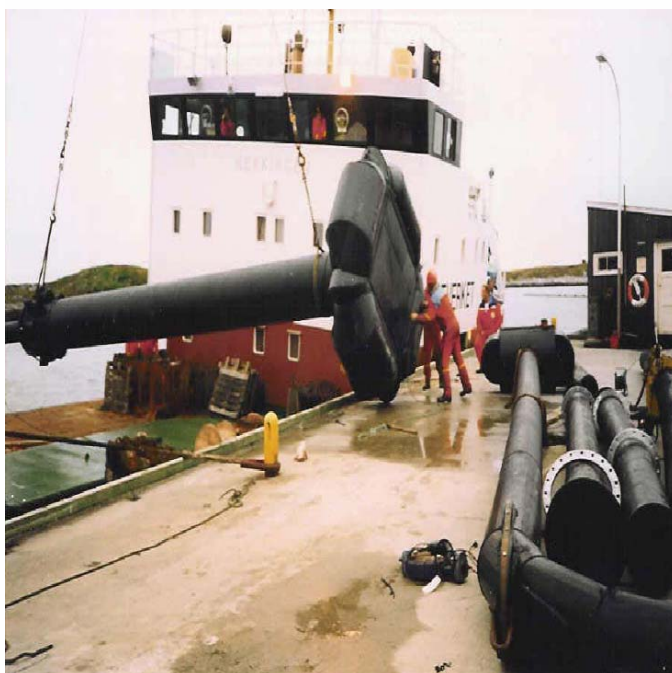
Figure 4.1-17 : WavePump à la mise à l'eau
