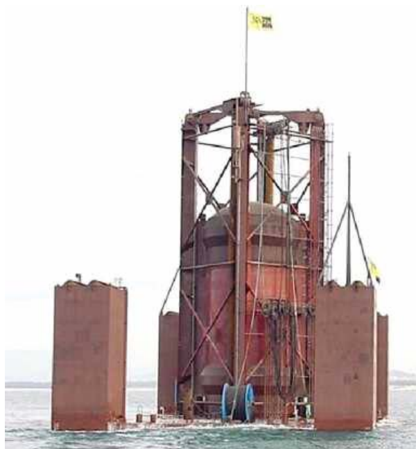
Figure 4.1-21 : AWS entre deux eaux
