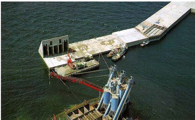
Figure 4.1-7 : Sakata en construction
