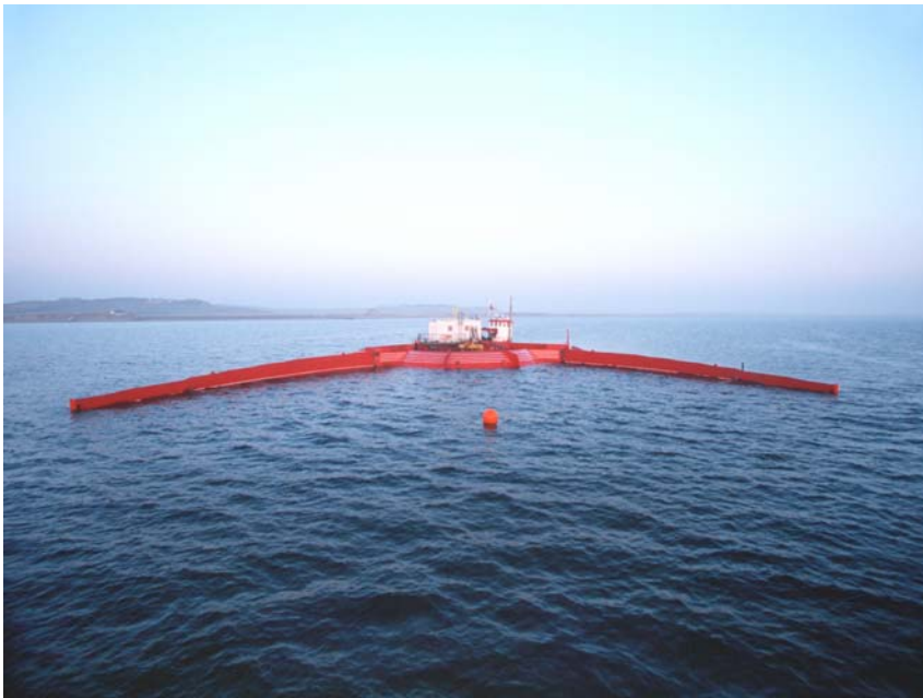
Figure 4.1-27 : Prototype de WaveDragon à l'eau
