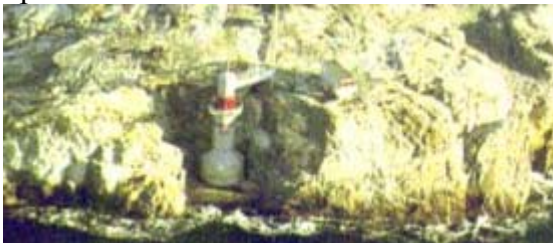
Figure 4.1-8 : vue aérienne de Toftestallen
