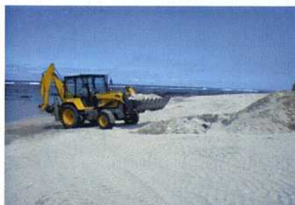
Travaux exceptionnels entrepris avec engins
