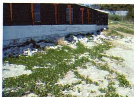
Traitement au pied d'un hôtel
