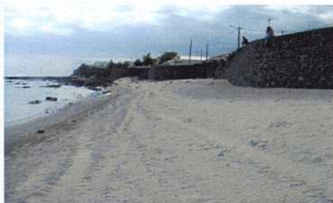
Restauration des plages érodées du Petit Boulevard à Saint-Pierre
