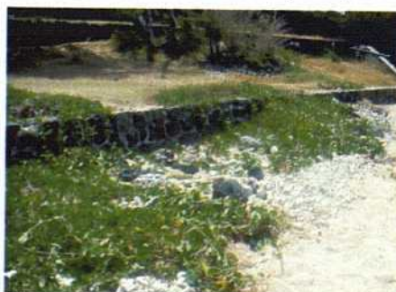
Intégration des murets maçonnés
