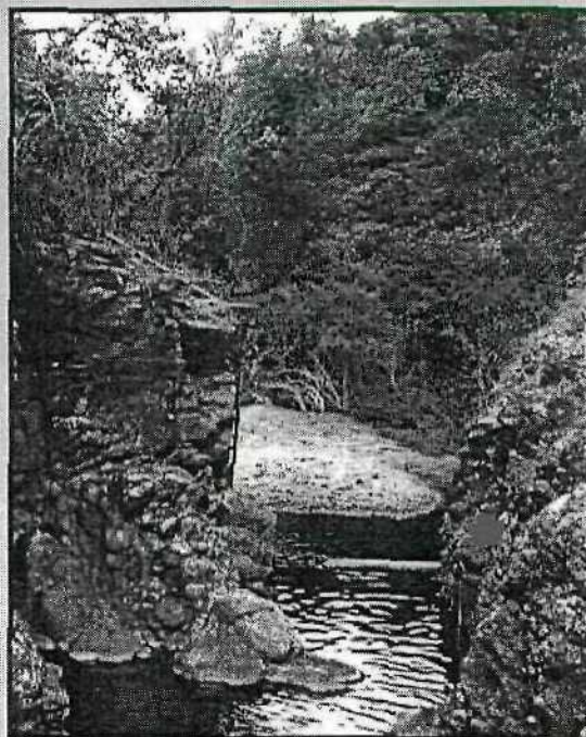
Un chenal de mesure encaissé !
