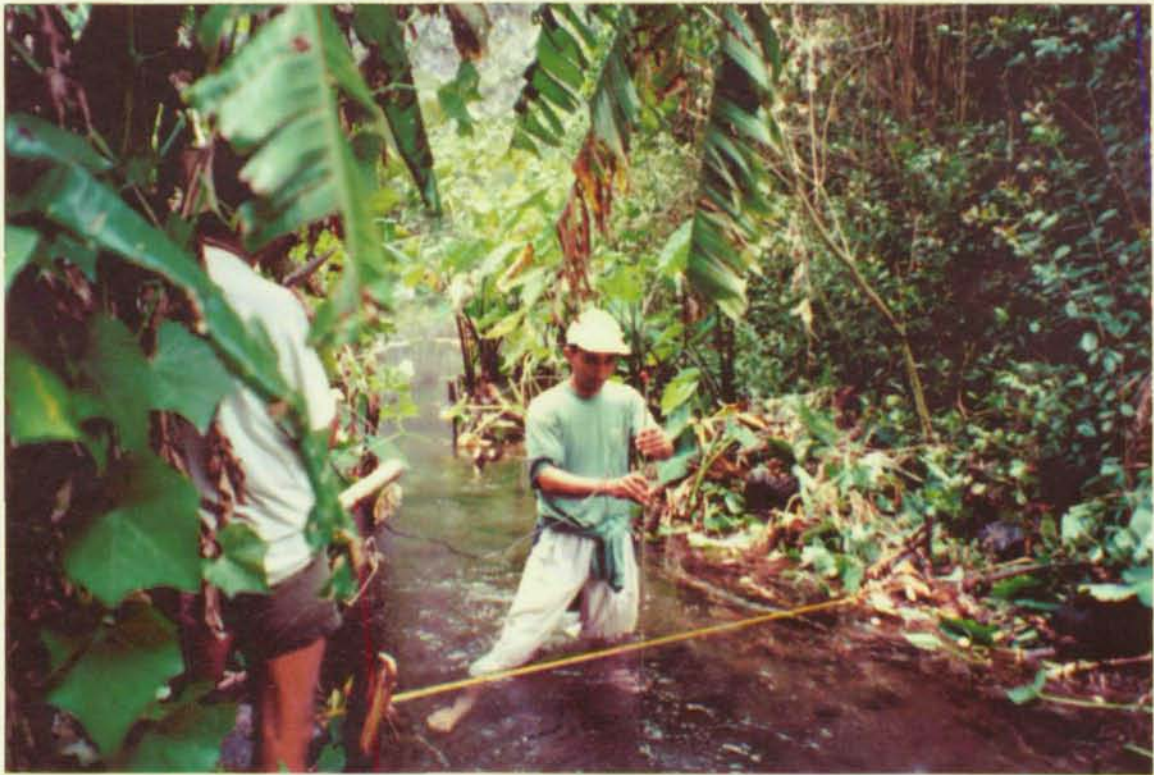
Jaugeage dans le "canal" d'amenée de la Source E. Avril
